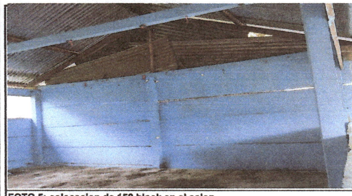
FOTO 5: colocacion de 150 block en el salon
